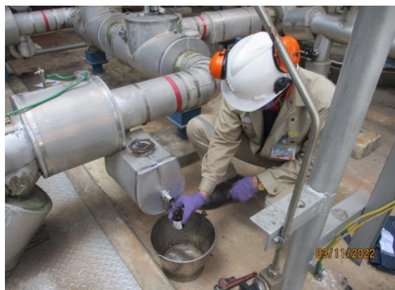
น้ำที่หมุนเวียนในระบบดักจับไอระเหยอะซิโตนด้วยน้ำ ในระบบ Acetone Scrubber Stack D-1904
